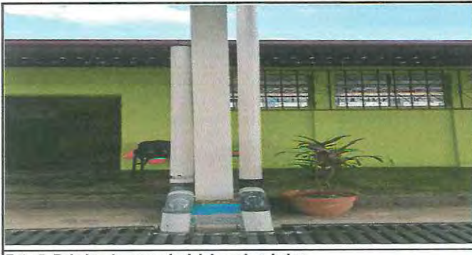
Foto 5: Bajadas de agua pluvial de ambos lados.
