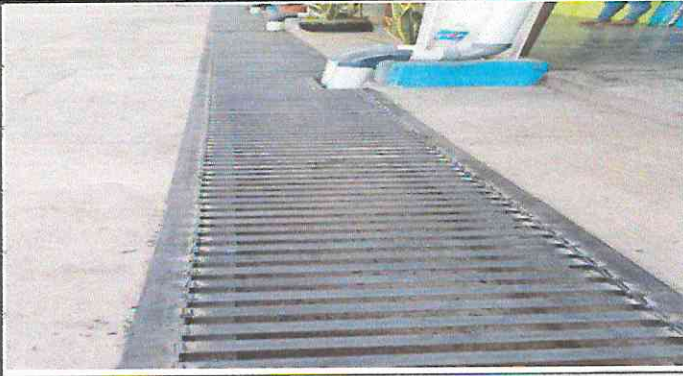
Foto 2: Cuneta de concreto y rejilla de metal
