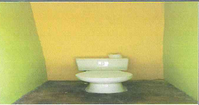
Foto 6: Instiación de 6 sanitarios
