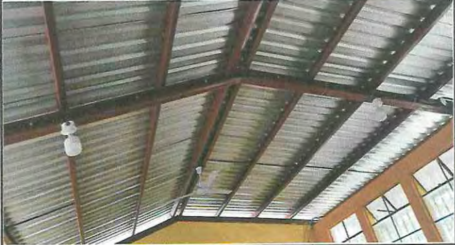
Foto 2: Cubiertas de Lamina, troquelada Aluzinc calibre 26
