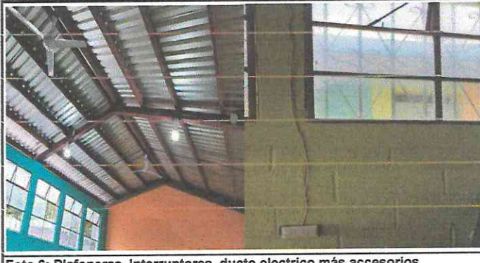
Foto 6: Plafoneras. Interruptores, ducto electrico más accesorios.
