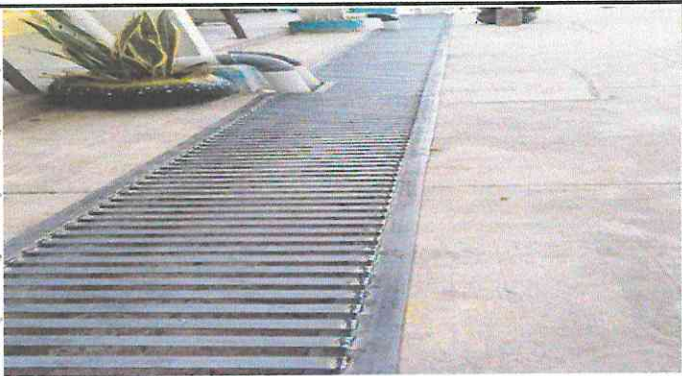
Foto1: Cuneta de concreto y rejilla de metal
