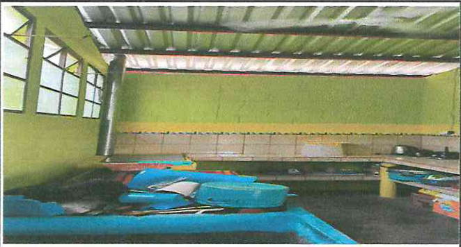
Foto 3: Reparación de estufa rural y cocina
