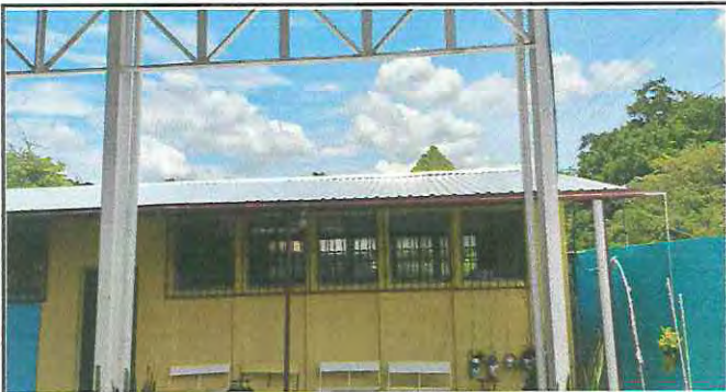
Foto 3: Canal de metal
