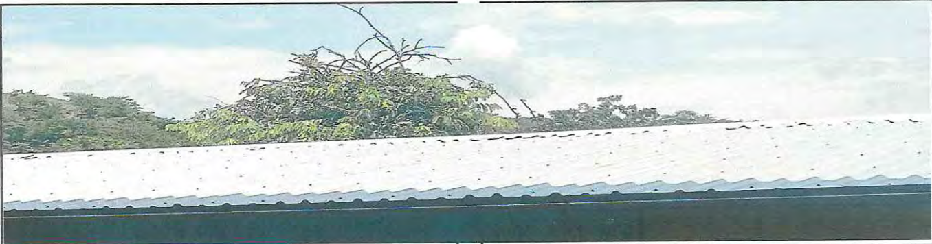
Foto 4: Capote de lamina, para lamina troquelada
