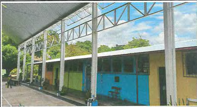
Foto 4: Canal de metal
