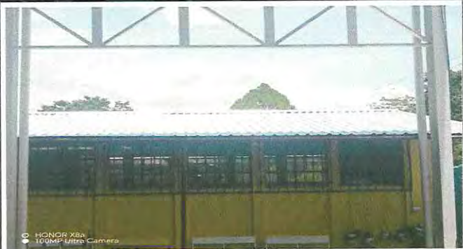
Foto1: Cubiertas de Lamina, troquelada Aluzinc calibre 26
