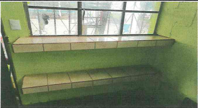
Foto 4: Reparación de estufa rural y cocina
