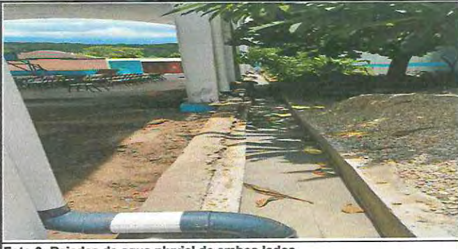
Foto 6: Bajadas de agua pluvial de ambos lados.
